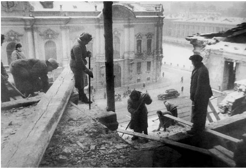
Разборка разрушенной части дома
